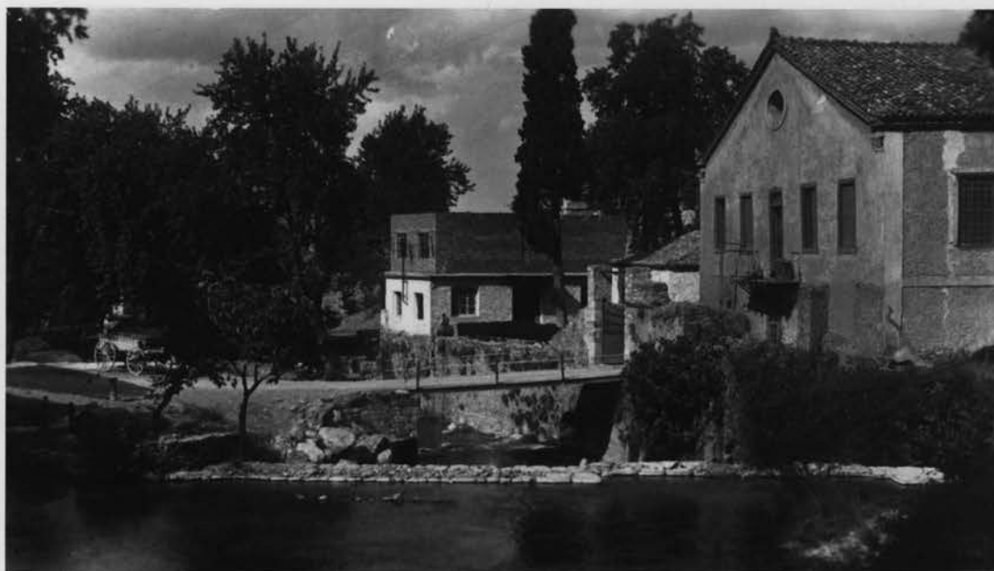
ΚΑΡΤ-ΠΟΣΤΑΛ. Δεκαετία 1930. Εκκοκκιστήριο-υφαντουργείο και βαφείο (2 ο κτήριο) των Θεόδωρου και Γεωργίου Καβρή – Ευσταθίου Πανουργιά – Θ. Ροζανίτου και Δ. Χατζόπουλου.
