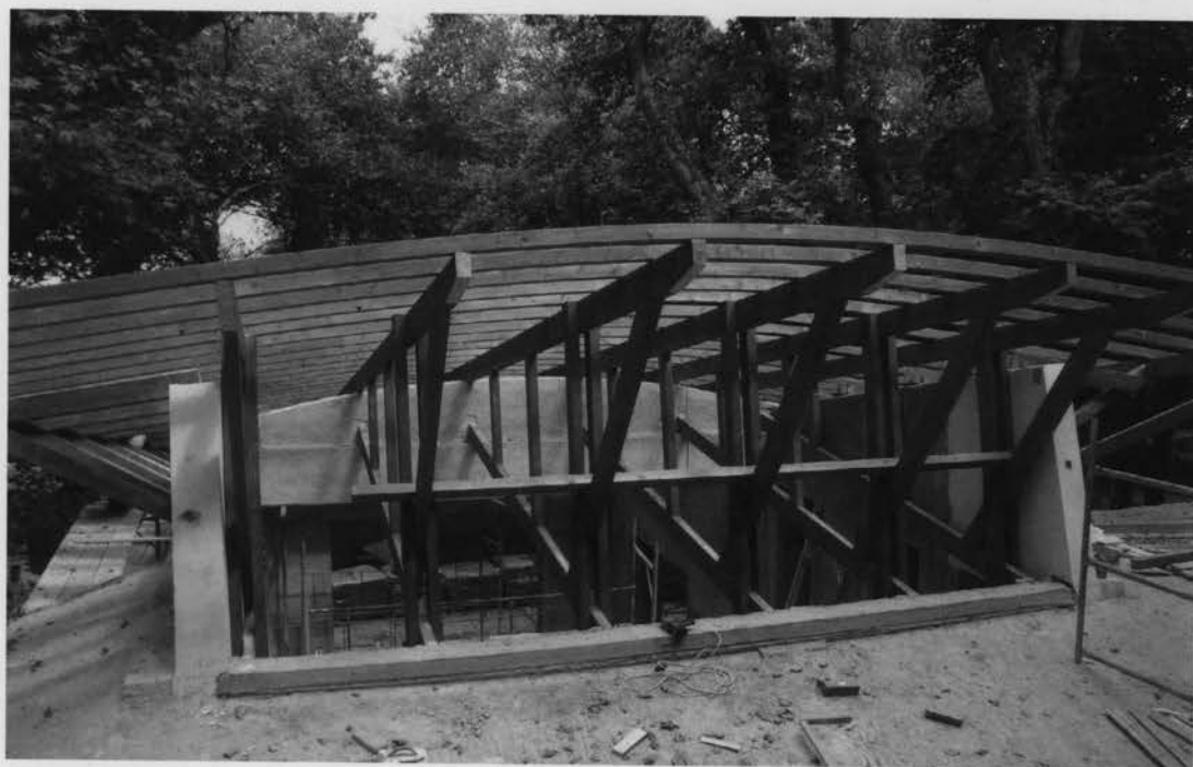
23 Ιουλίου 2013. Εργασίες ανακατασκευής του Ξενία επί Δημαρχίας Νικολάου Γ. Παπαγγελή.
