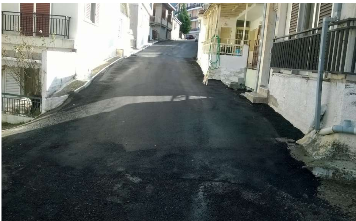
Οδός Ρήγα Φεραίου, 85 μέτρα
